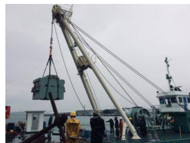
《A フレーム クレーン》
